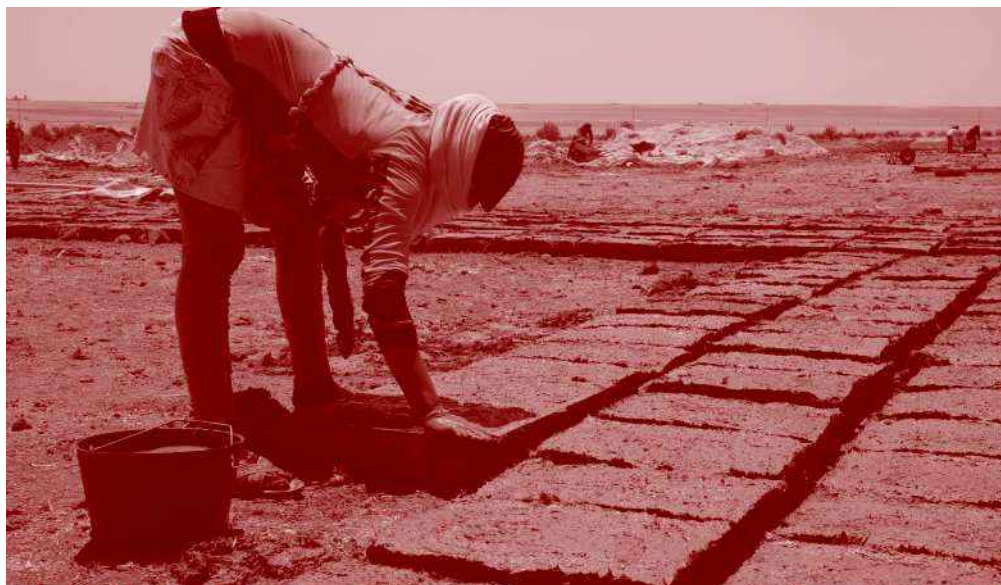
Comienza la construcción de un centro para mujeres. Foto: Equipo de medios de comunicación, Jinwar.
